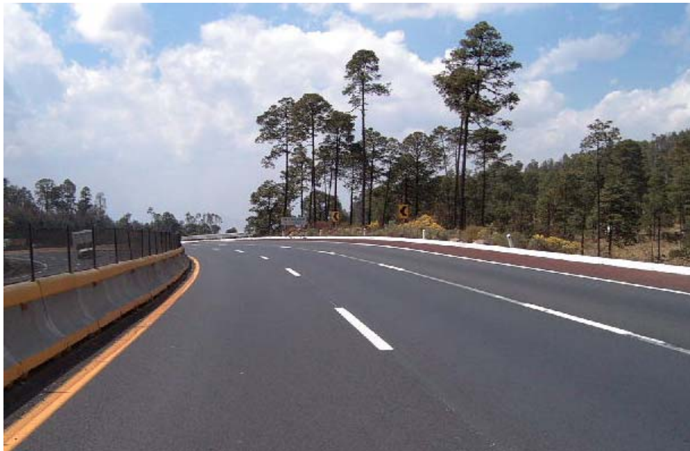
Figura 2.4 Curva horizontal izquierda, con distancia de visibilidad deficiente por no cumplir con la distancia libre de obstáculos mínima
