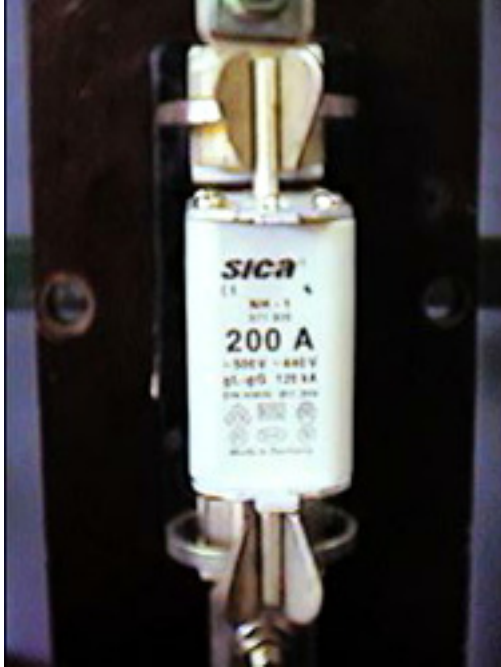
Cartucho fusible de alto poder de ruptura tipo NH tamaños 1 y 2 hasta 500 V. según normas DIN 636 o IEC 269
