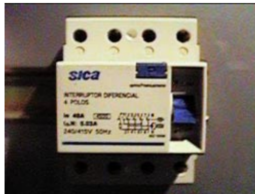
Interruptor diferencial tetrapolar SICALIMIT 4 x 40A - I_{\Delta} = 0,03A
