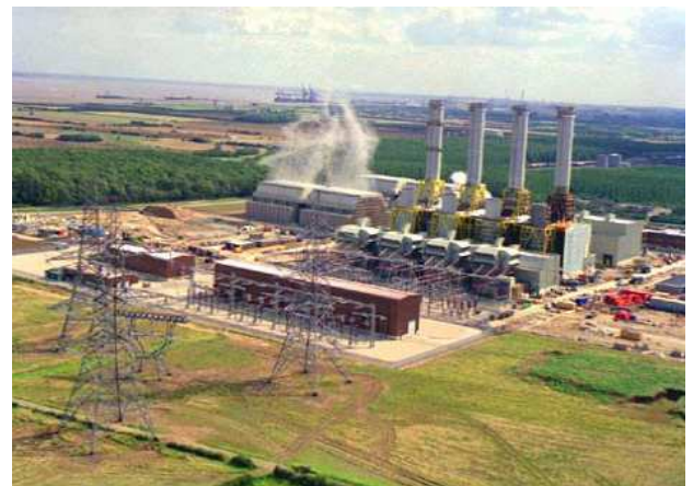
Transformador a alta tensión junto a una central
